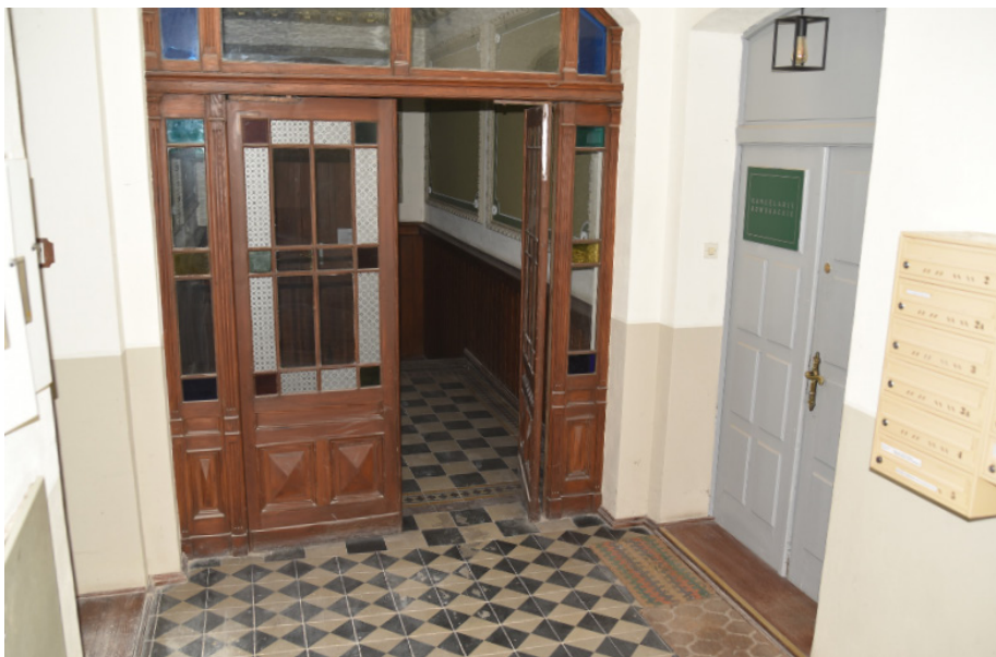
Fot. 12. Widok wnętrza klatki schodowej przy pl. Kopernika 4 – stan na 2023 r. Zdjęcie: N. Łozińska
