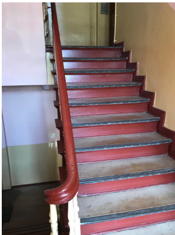
Fot. 7. Widok wnętrza klatki schodowej przy ul. Ozimskiej 24 przed remontem – stan na 2019 r. Zdjęcie: N. Łozińska
