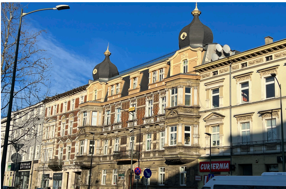
Fot. 10 Widok elewacji frontowej kamienicy przy pl. Kopernika 4 stan na 2023 r. Zdjęcie: N. Łozińska
